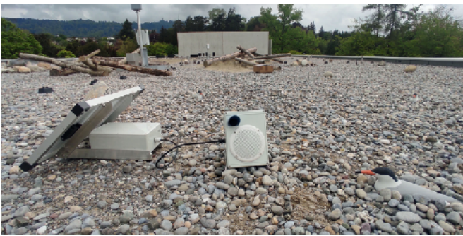
Blick auf das neue Flachdach mit der Anlockanlage und einer Flusseeschwalben-Attrappe.
