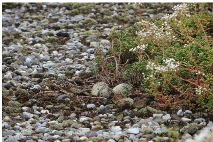
Flusseeschwalben-Nest auf Flachdach
