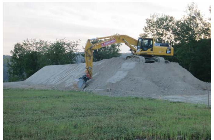
Neues Uferschwalben-Depot in Glattfelden während dem Bau 2014. © Orniplan
