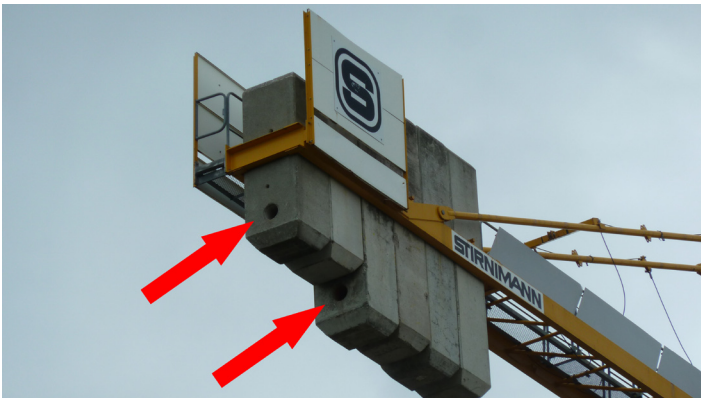
Ungewöhnlicher Dohlenbrutplatz: Öffnung im Gegengewicht eines Baukrans (Foto: Orniplan).
